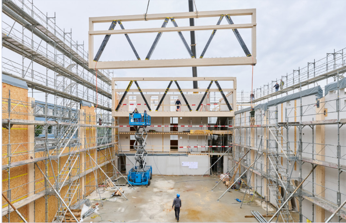
Die Holzelemente sind montiert, bis Ende Jahr folgen Dach, Fenster und Türen.
