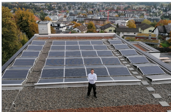
Die Schule Sonnenberg wurde mit PV-Anlagen versehen.
