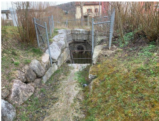
(c) Ju_01 – Ju_02: Eindolung Bauwerk
