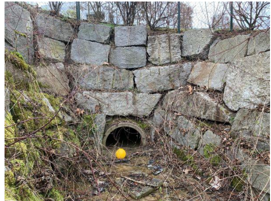
Ju_01: Auslauf Betonrohr, unten liegt Geschiebe (Schlamm)
