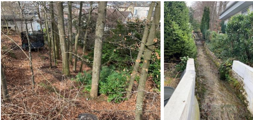
Abbildung 8 Foto links: Blick auf den oberen Teil des Abschnitts Wa_02; Foto rechts: Blick vom Einlauf in die Eindolung Kirchstrasse bachaufwärts in den Abschnitt Wa_02
