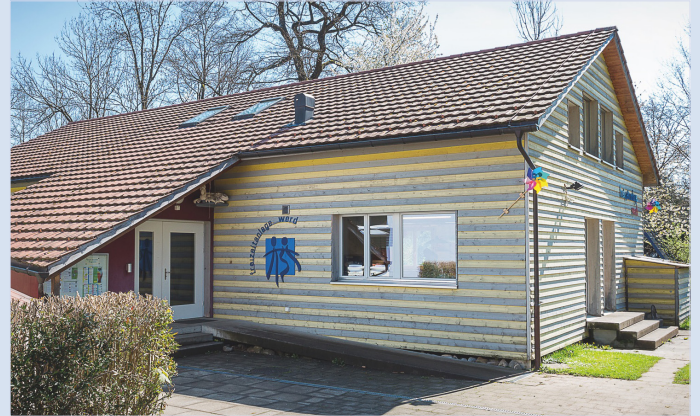
Das heutige Gebäude wurde 1999 in Betrieb genommen.
