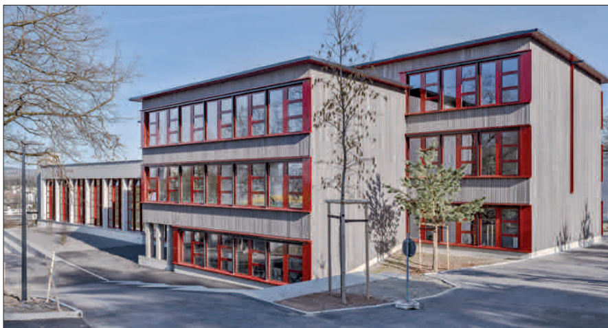
Der neue Holzbau ergänzt das bisherige Schulareal Sonnenberg.
