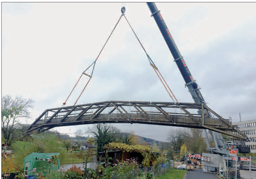
Der neue Tüfi-Steg schwebte an einem Stück über die Sihl.
