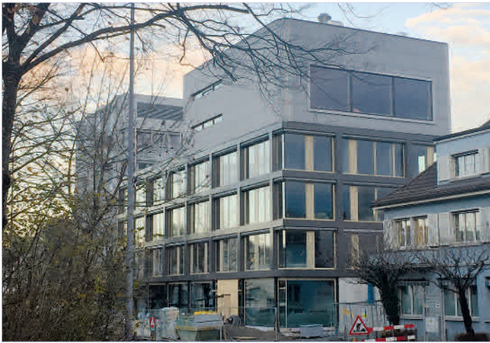
Das Gerüst ist weg – im Innern stehen aber noch einige Arbeiten an.
