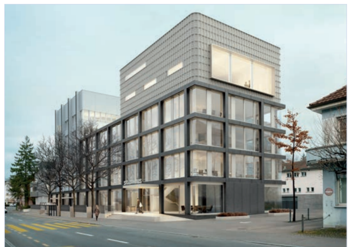
Die Erweiterung des Stadthauses erfolgt in Holzbauweise.
