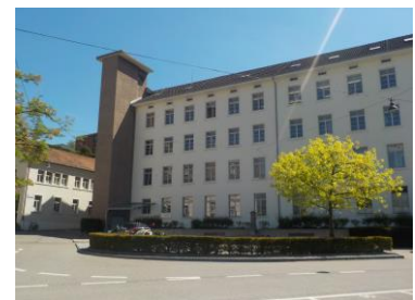
Ehemalige mechanische Seidenweberei Adliswil (MSA)
