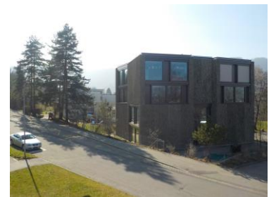
Erweiterungsbau Schulhaus Kopfholz
