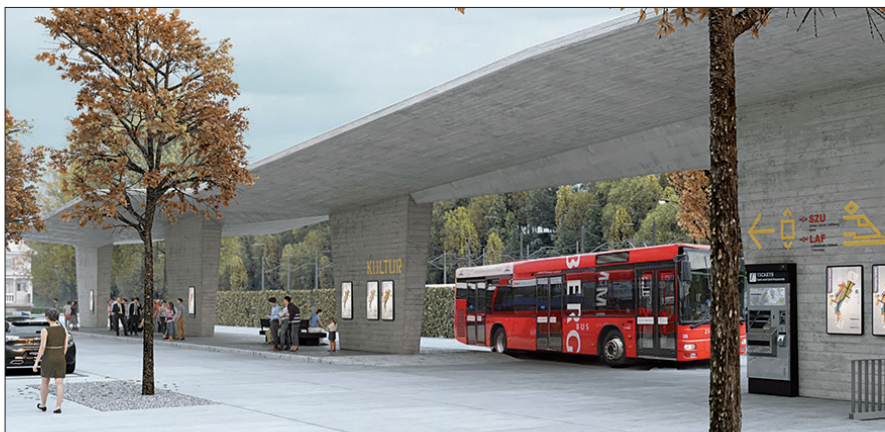
Die Arbeiten rund um den neuen Bushof Adliswil dauern von Oktober 2019 bis Ende 2021.
