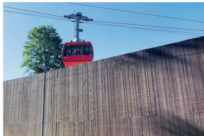
Das Reservoir Rellsten befindet sich nahe der Luftseilbahn Felsenegg.
