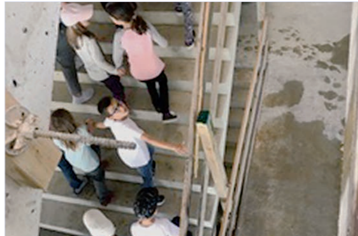
Schülerinnen und Schüler besichtigten die Baustelle „ihres“ neuen Schulhauses.
