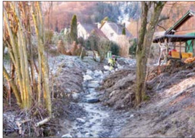
Im Schwarzbach bremsen Steine das Wasser im Falle eines Hochwassers.
